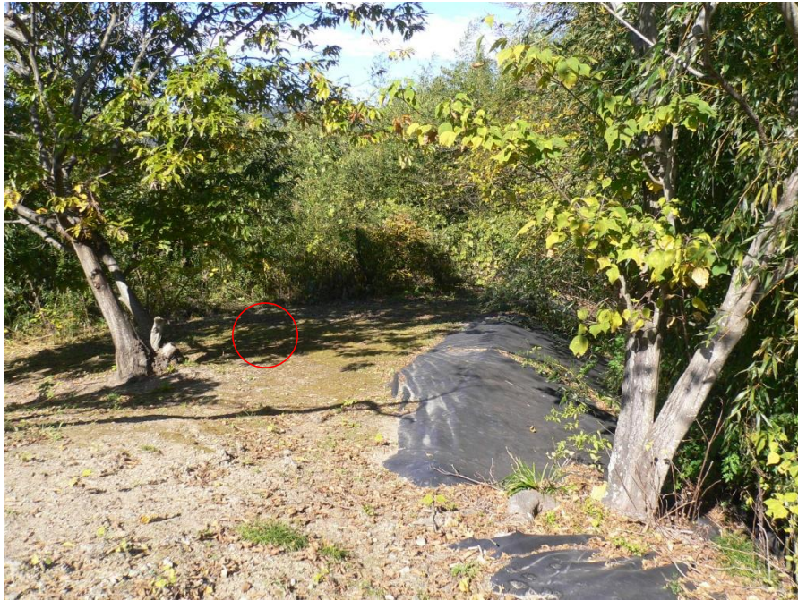
写真 4-2-3 新規ボーリング No. 3 (擁壁基礎計画部付近)
