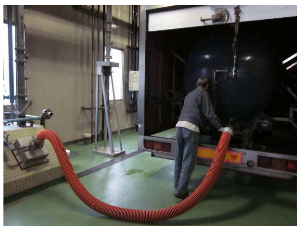
【汚泥搬入状況】
