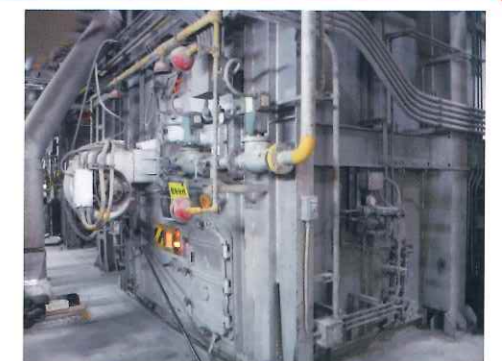
焼却炉の外側
