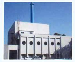
▲一色清掃工場(焼津市) (120トン/日×1炉)
